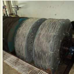
Instalasi Pengolah Air Limbah Hotel dengan Sistem Rotating Biological Contractor
